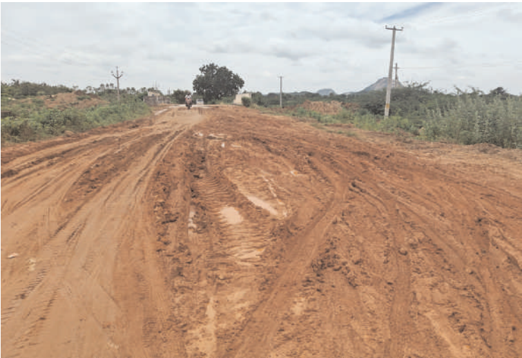
ఈ రోడ్డు వెంబడి నిత్యం రద్దీగా ఉంటుంది. వారం రోజుల్లో కల్వర్టు రోడ్డు నిర్మాణం చేపట్టకపోతే ప్రజలను ప్రయాణికులను ఏకం చేసి పెద్ద ఎత్తున ఆందోళన చేస్తామని హెచ్చరించారు.
